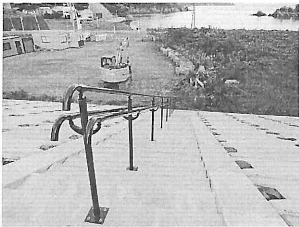
写真2 歌津・寄木の防潮堤 2021.10.29
