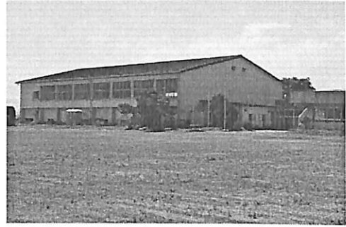
写真21 関上小学校体育館. 2013.8.5
