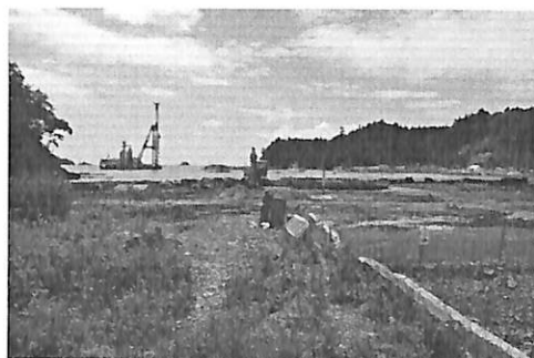
写真9 伊里前漁港復旧工事, 2013.8.4
