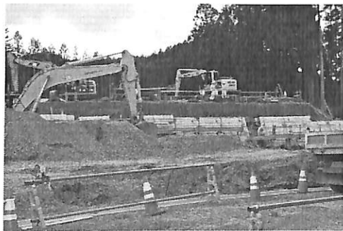
写真1 入谷住宅・災害公営住宅造成地。2013.8.4
