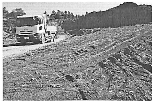
寄木地区高台移転地の造成工事2013年8月2日
