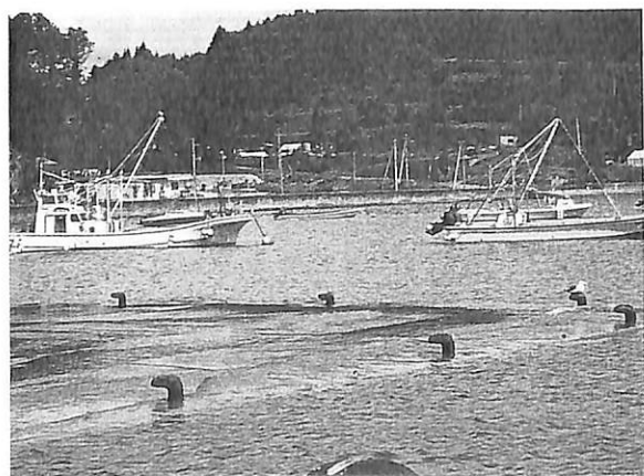
11. 沈下した岸壁 (寄木)
