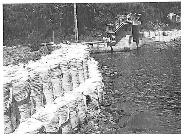
12. 仮の護岸 (寄木)
