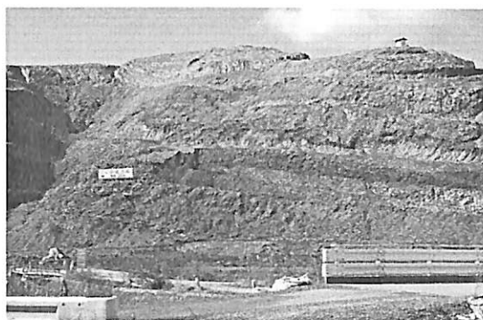
写真9 志津川地区中央団地の造成 2015.1.24
