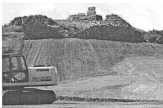
写真10 志津川地区東団地の造成 2014.9.2
