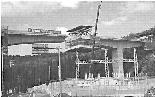
写真1の3 南三陸道磯の沢橋脚 2014.9.1
