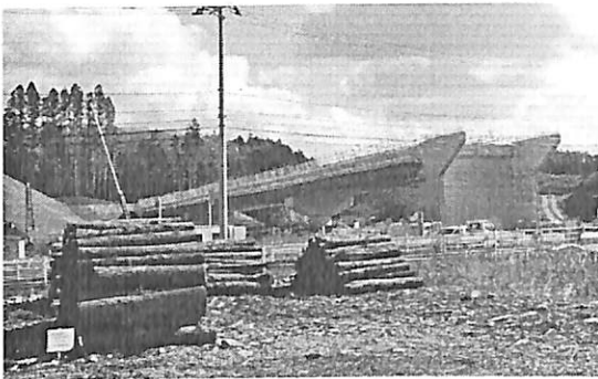
写真1の2 南三陸道志津川インター工事の進捗 2015.1.23
