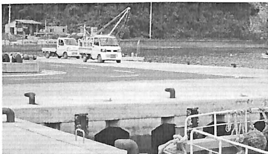
写真19の1 整備されたものの震災以前よりも高い岸壁（寄木漁港）2014.9.15
