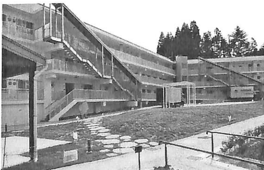
写真5の3 町営入谷復興住宅 2014.9.1
