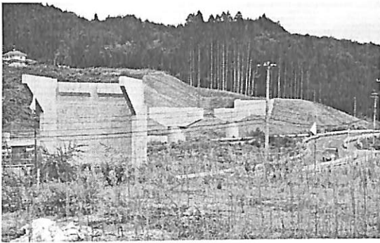
写真1の1 南三陸道志津川インター工事現場 2014.9.1
