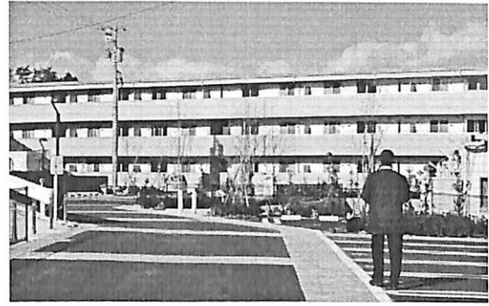
写真5の5 町営枳沢復興住宅 2015.1.24
