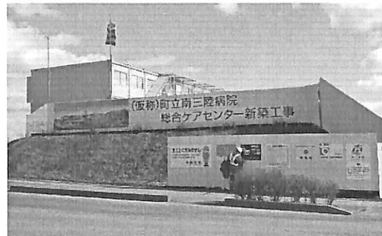
写真4 新町立病院・総合ケアセンター建設現場 2014.1.24
