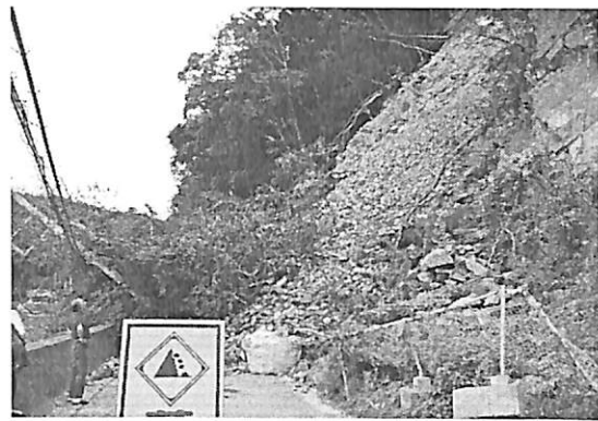
写真20 寄木漁港前の崖の崩落 2014.9.4
