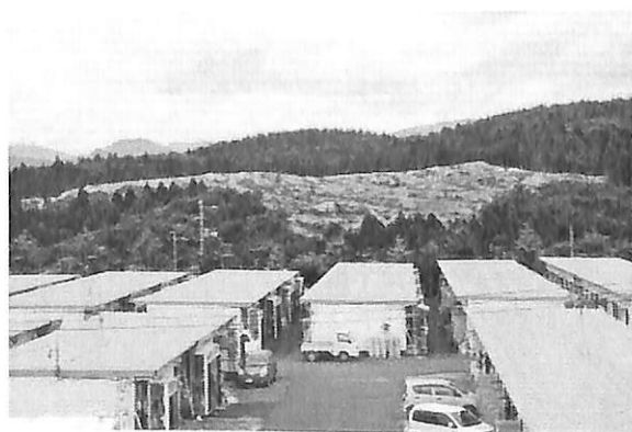
平成の森団地と造成工事中の耕沢団地用地 2014年9月4日
