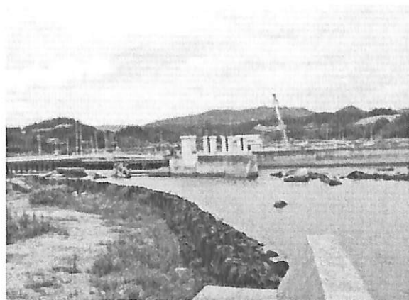
志津川地区水尻川河口付近 崩壊した水門がそのままになっている。左に国道45号線の仮設橋梁 遠景は造成工事中の高台移転用地 2014年9月1日
