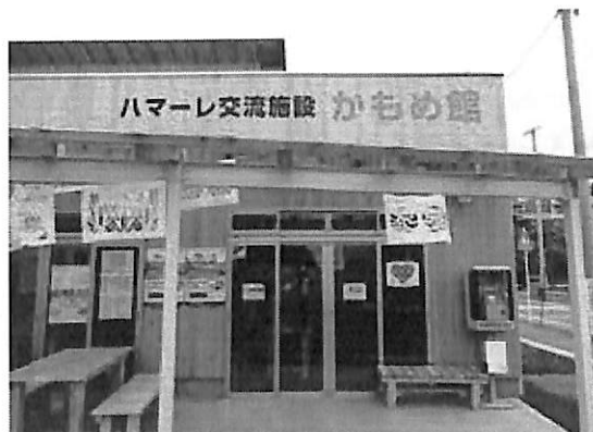
写真4 交流施設・かもめ館 2018.9.3
