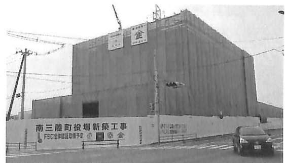
写真2 建設中の南三陸町役場 2017.2.20
