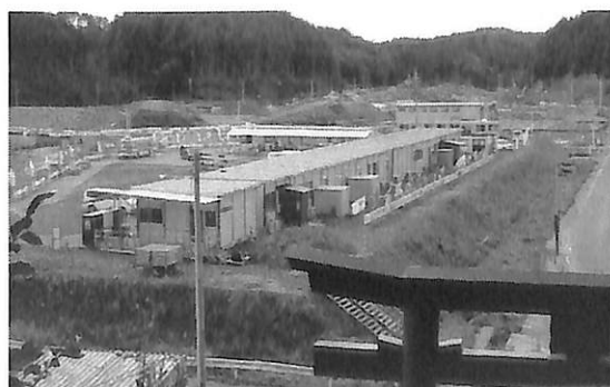
写真5の1 仮設の伊里前商店街 2017.2.10
