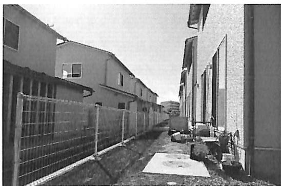
写真8の1 災害公営住宅(志津川中央団地) 2017.2.18
