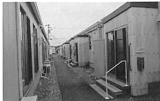
写真9の2 南方仮設住宅 2017.2.20
