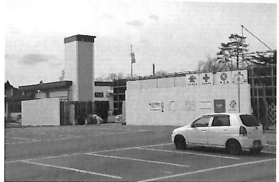
写真7 建設中の歌津総合支所 2017.2.22
