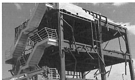
写真1の3 保存作業中の防災対策庁舎 2017.2.18
