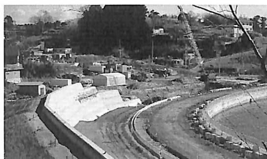
写真1の2 袖浜・建設途上の防潮堤 2017.2.18
