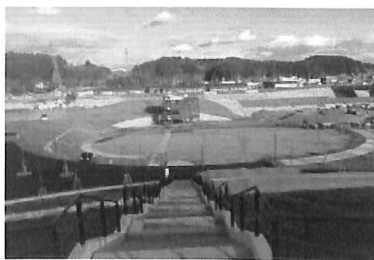
写真9 旧防災対策庁舎を望む復興祈念公園 2020.2.7
