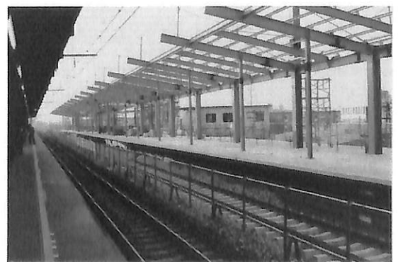
写真4 赤い鉄骨の屋根がホーム (1988年10月15日)
