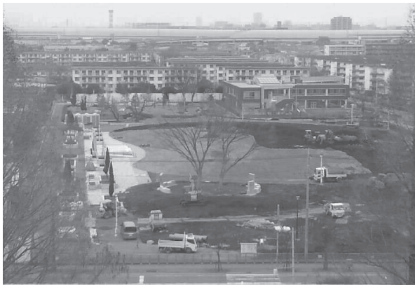
図2 獨協大学の中央棟8階から見た開園前(2015年2月25日)の松原団地記念公園の工事の様子。
