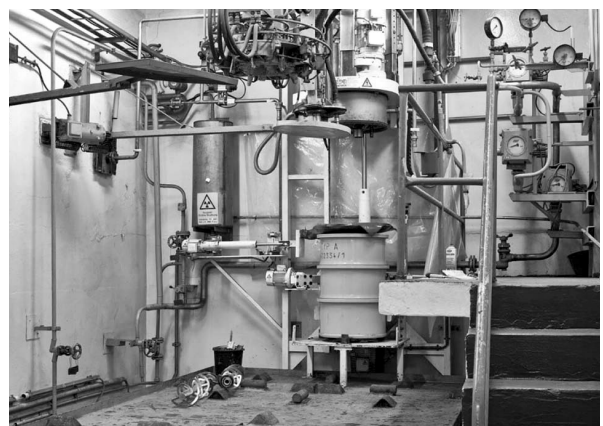
写真⑨、写真⑩ モアスレーベン坑内の設備 連邦放射線保護庁提供
