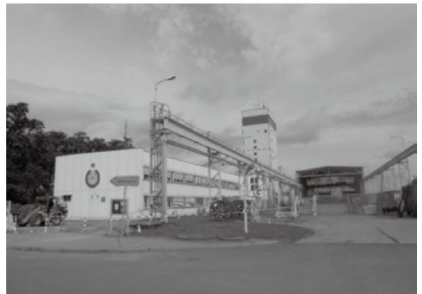
写真1 モアスレーベン最終処分場の外観
